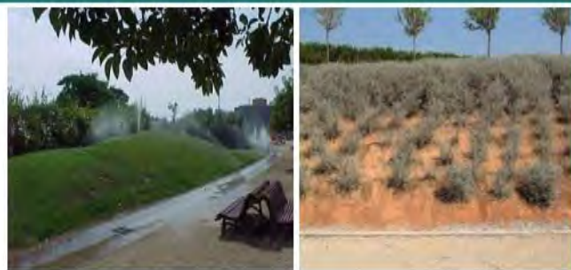
Fig. 3.4. Exemples de manca d'uniformitat del sistema de reg per aspersió (dreta) i degoteig (esquerra) que produeixen zones pavimentades que reben aigua i zones amb plantes mortes degut al mal funcionament dels degotadors
